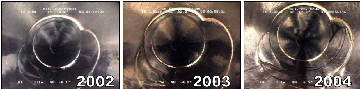
Abbildung 16 Vergleich eines bestimmten Rissbildes in Jahresreihen
